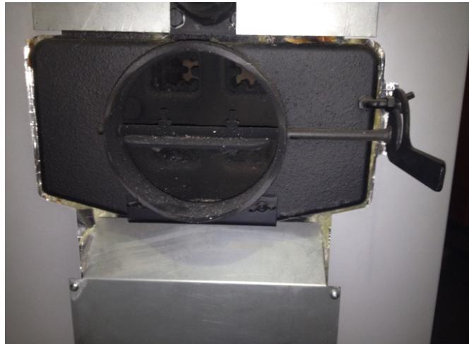
Le volet situé sur la porte de chargement sert à l'admission de l'air secondaire dans la chambre de combustion.
