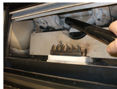
Fig. 38 - Nettoyage de la partie supérieure à cendre
