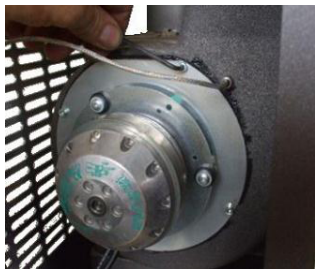
Fig. 42 - Nettoyage de l'aspirateur des fumées: phase 1
