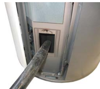
Fig. 46 - Nettoyage du canal
