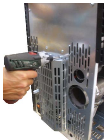
Fig. 57 - Enlever le couvercle arrière
