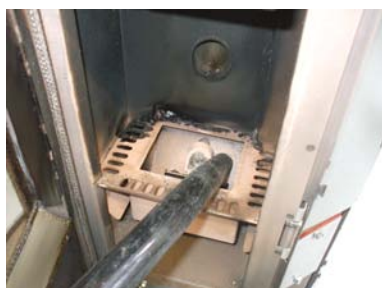
Fig. 29 - Nettoyage l'espace du brasero
