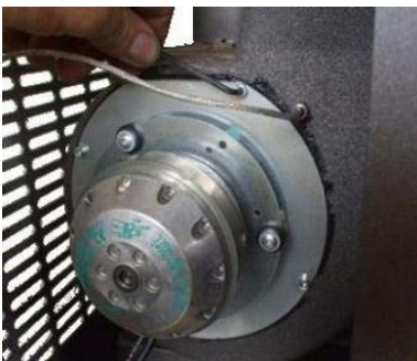
Fig. 36 - Nettoyage de l'aspirateur des fumées: phase 1
