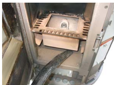
Fig. 30 - Nettoyage l'espace du tiroir à cendre
