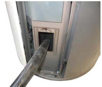
Fig. 55 - Nettoyage du conduit de fumée
