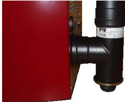
Fig. 35 - Nettoyage du conduit de fumée
