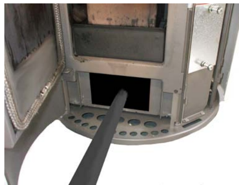
Fig. 34 - Nettoyage de la chambre des fumées
